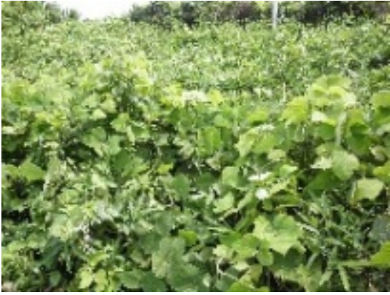
広良・利左工門池の堤体
